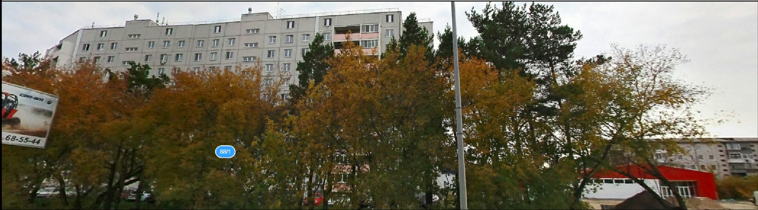
Развертка фасадов по Тобольскому тракту (фотофиксация)
