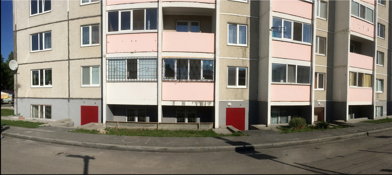
Фотофиксация. Фрагмент изменяемой части фасада.
