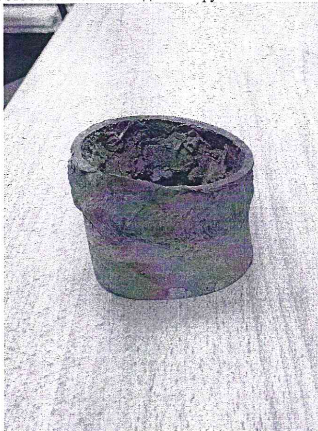
Фото №4. Внешний вид части трубы системы ГВС.
