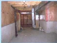
Ремонт подвальных помещений
