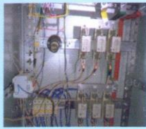
Ремонт внутридомовых инженерных систем
